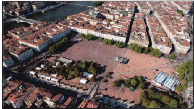
Figure 25 : vue aérienne d'après le réaménagement
