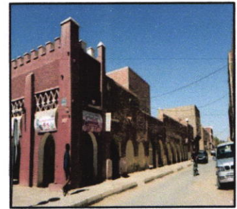
Figure 100 : Commerce sur la façade nord
