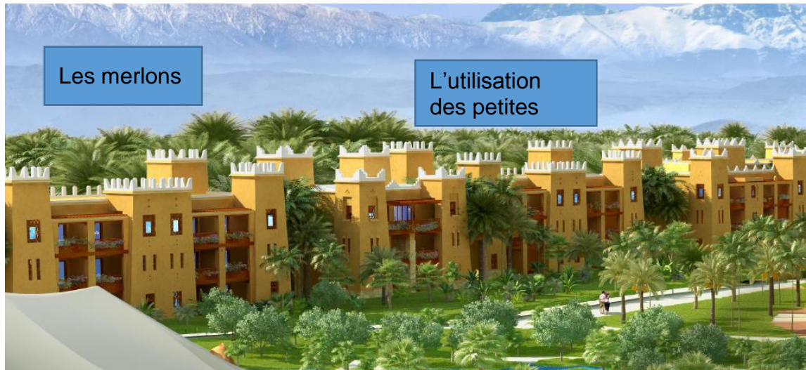
Figure 3.42 : vue générale sur quartier résidentielle. (Dossier de Presse : Pierre & Vacances-Center Parcs)
