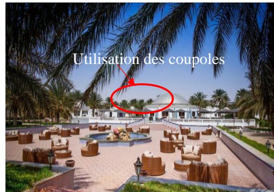
Figure 3-27 : Façade extérieure ( http://www.hotel-lagazelledor.com )
