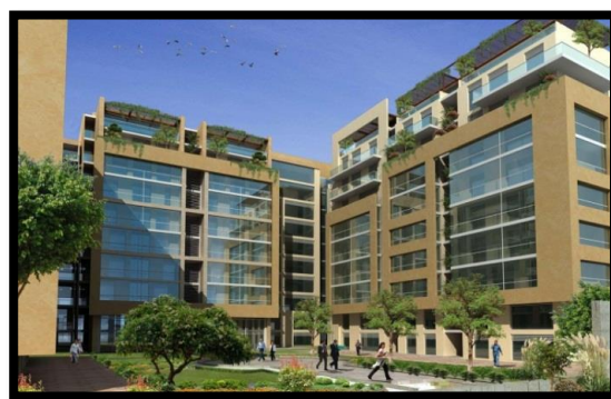
Figure 60: Façade des bâtiments A et C
