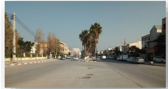
Figure 105: vue sur le boulevard Larbi Khaled Source : pris par l'auteur 2018
