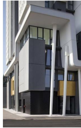
Figure 47:piliers inclinés Source : Opcit
