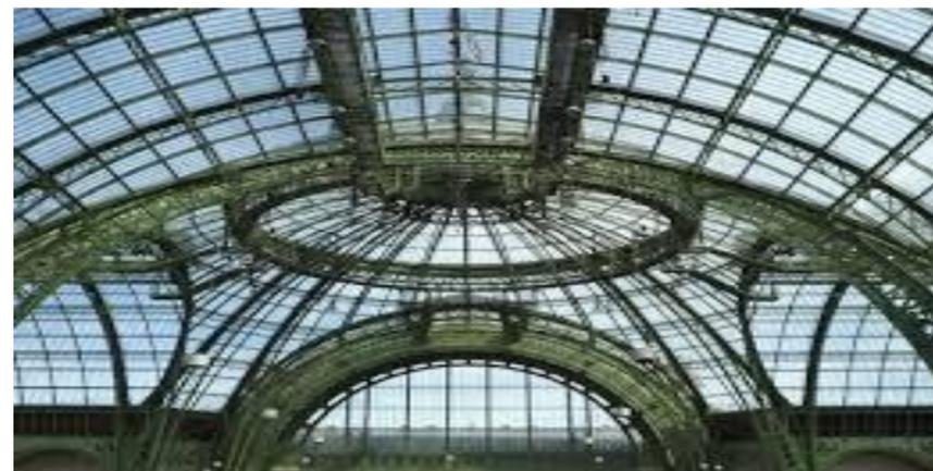
Figure5. 59: Structure métallique en treillis
