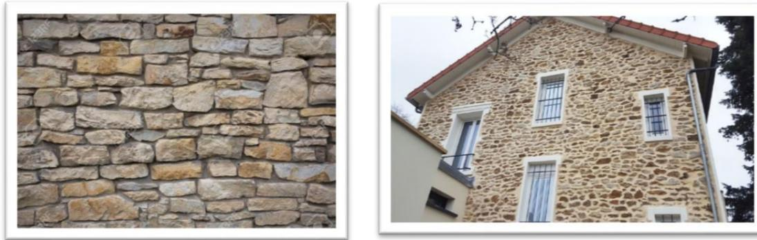
Figure5. 62: Exemple d'un mur porteur en pierre (Google image)
