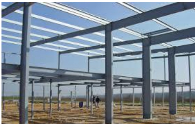
Figure 105 Poteaux poutres métallique
