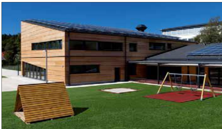
Figure 20 Ecole maternelle passive en bois (Construire et rénover de façon responsable dans les Alpes : 7- 8)
