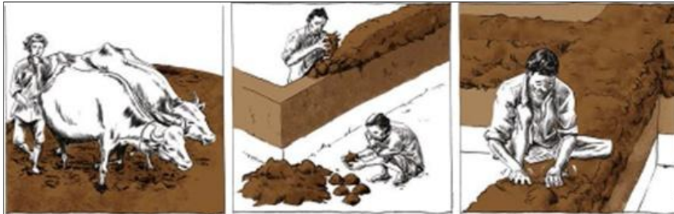
Figure 25 Technique de construction en Bauge(Terra Award, Dominique Gauzin Müller 2015)
