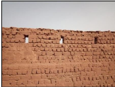
Figure 25. Appareillage du mur d'enceinte de l'agham. source : les auteurs 2019.
