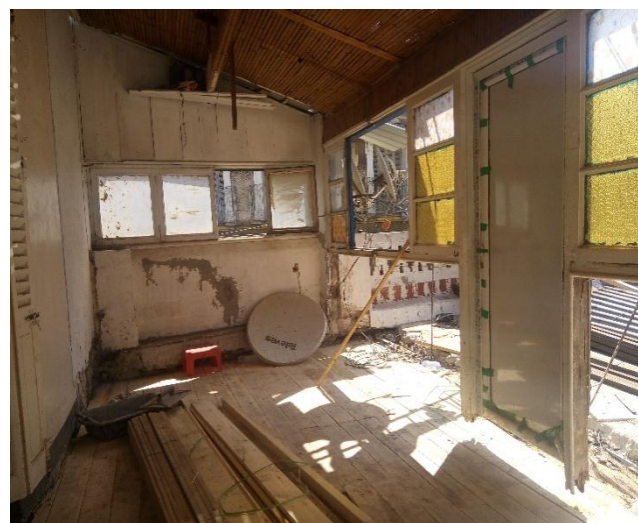
Figure 13 travaux de réhabilitation, 09 Rue Ahmed CHAIB
