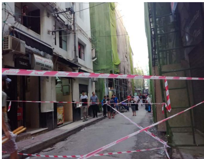
Figure 21 risque d'effondrement d'un mur porteur, quartier Ahmed CHAIB Source :Auteur
