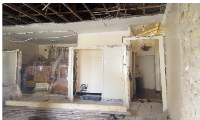
Figure 22 reprise des planchers en cours, 09 rue Ahmed CHAIB Source : Auteur
