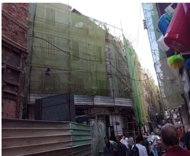
Figure 14 travaux de réhabilitation en cours, rue Ahmed CHAIB
