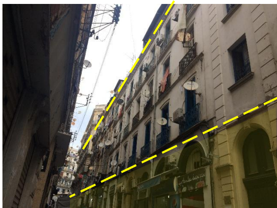
Figure 17 la tripartition des façades de la rue Ahmed CHAIB avec RDC commercial Source : Rapport Bureau d'étude, traité par auteur.
