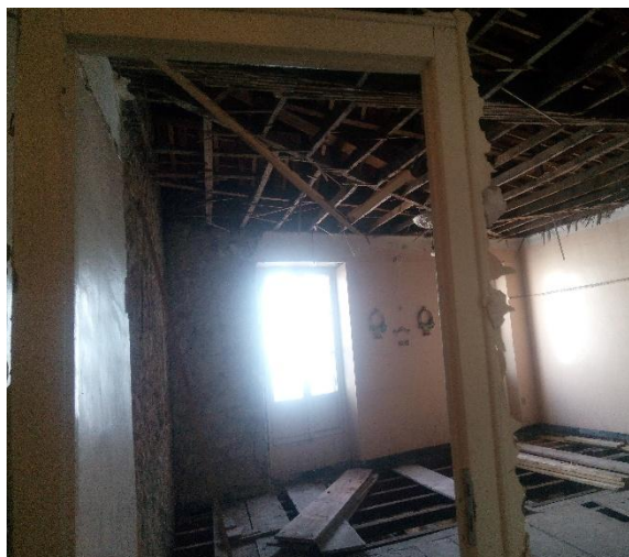
Figure 24 reprise des planchers en cours, 09 rue Ahmed CHAIB
