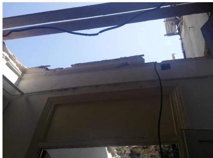
Figure 23 reprise des planchers en cours, 09 rue Ahmed CHAIB Source : Auteur
