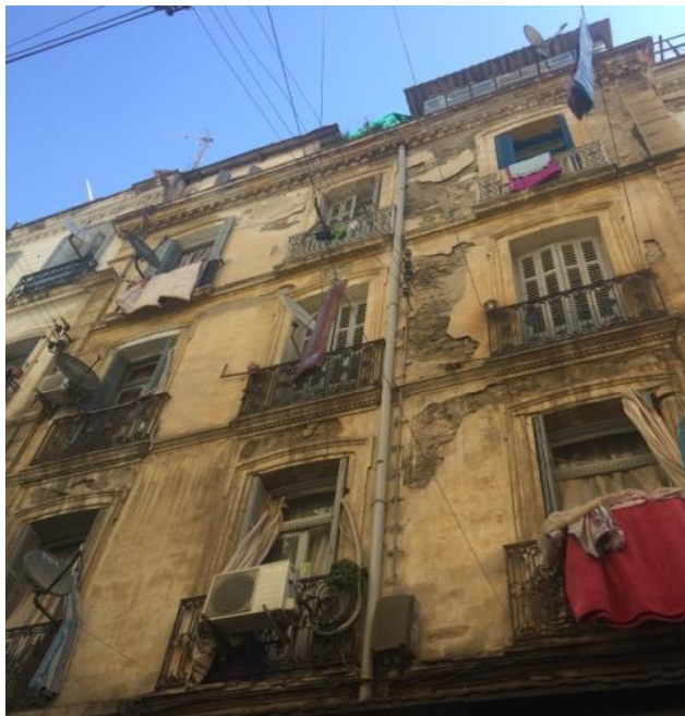
Figure 11 photo sur les pathologies des façades de la rue Ahmed CHAIB
