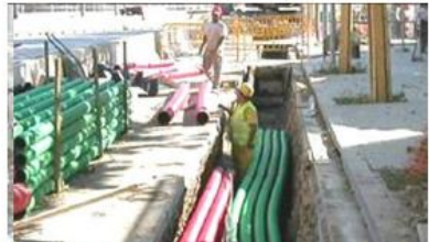
NOUVEAUX RESEAUX D'ENERGIE ET TELECOMMUNICATIONS
