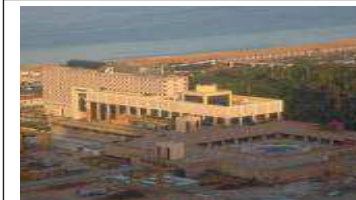
Figure 3- 33 : Hôtel Sofitel Source : google image
