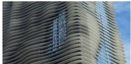
Figure 148 : Gratte-ciel avec système de protection solaire
