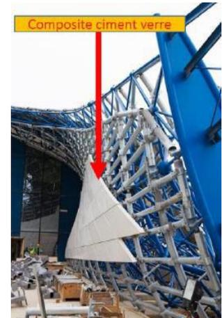
Figure 139<sup>xxix</sup> : pose du béton ciment verre sur la structure
