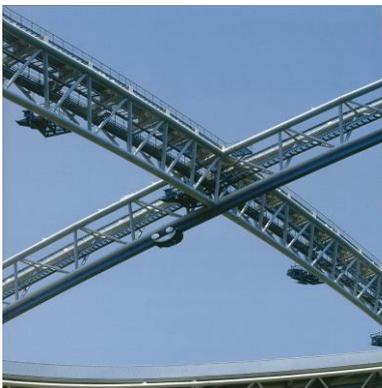
Figure 140<sup>xxx</sup> la jonction entre 2 poutres tridimensionnelles (K)
