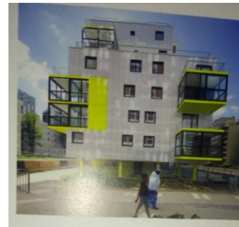
Figure 28 Façade secondaire Source : vers de nouveaux logements sociaux
