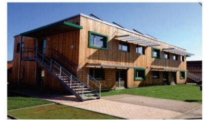
Figure13: Une des réalisations du groupe Chênelet. source : www.chenelet.org
