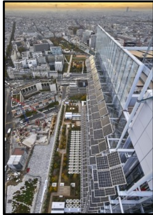
Figure II - 22 : Panneaux photovoltaïques de TGI de Paris Source : http://www.didierfavre.com
