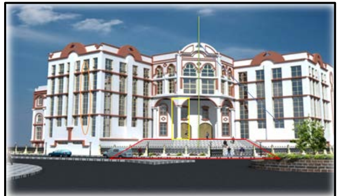
Figure II - 16 : vue de façade du tribunal de Harrouch Source : Mémoire réalisé par Aissoussi Imene traitée par l'auteur
