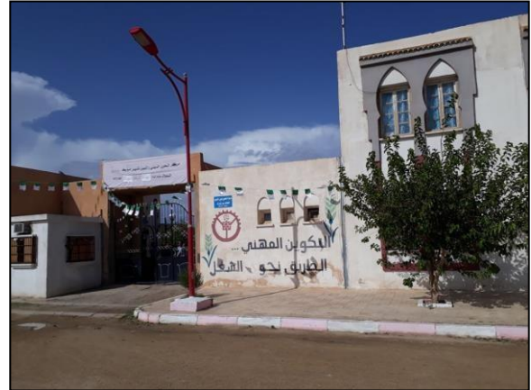
Figure 29 : l'entrée secondaire. Source : les auteurs
