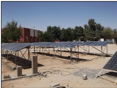
Figure 65 L'installation des panneaux sur une structure métallique surélever au sol
