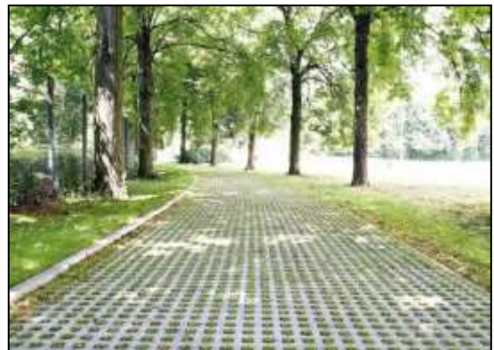
Figure 124 : Allée d'espace vert réalisée en revêtement alvéolaire, engazonné. Source : Google image.
