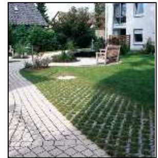
Figure 137 : exemple de dalle alvéolée. Source : Google image.
