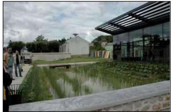
Figure 151 : Bassin paysager en eau – Mairie de Marcoussis. Source : Eaux pluviales urbaines.
