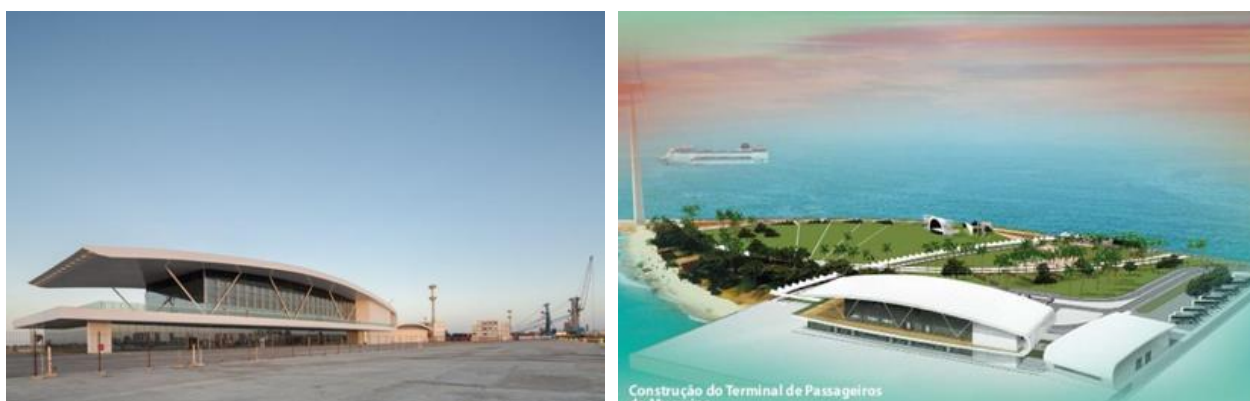
Figure 12 : forme et volumétrie de la gare , source : pinterest , traiment : auteur
