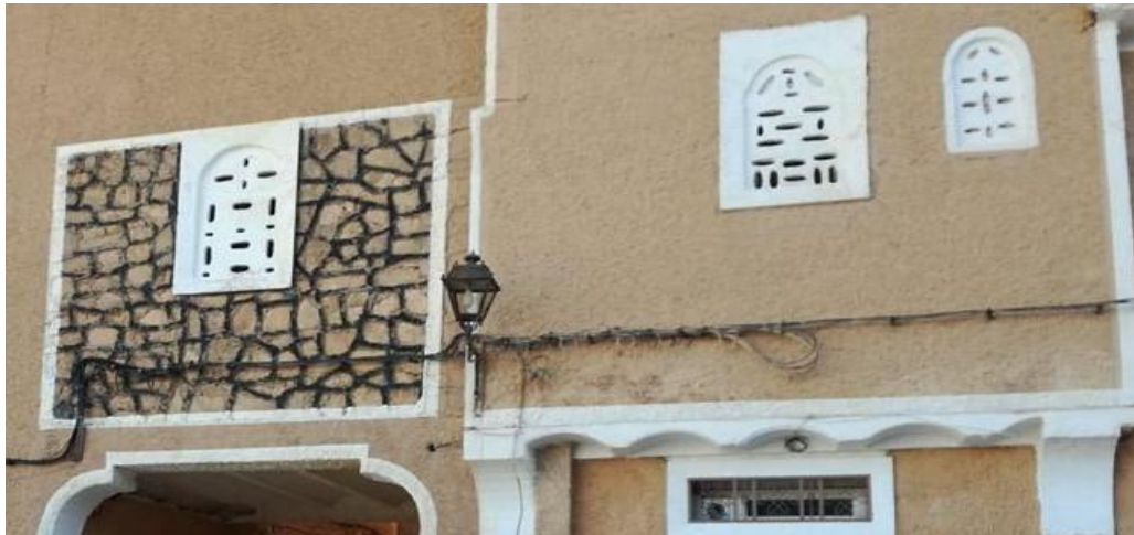
Figure35: Revêtement extérieur de façade Source : http://tafilelt.com
