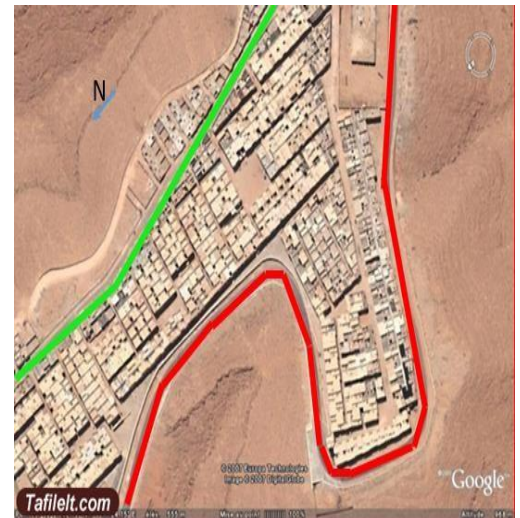
Figure28 : L'accès à l'intérieur du ksar
