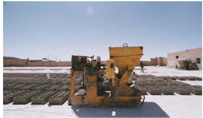
Figure37 : les machines de construction
