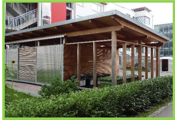
Figure 3.18 :abri vélos et poubelles, Vauban, fribourg
