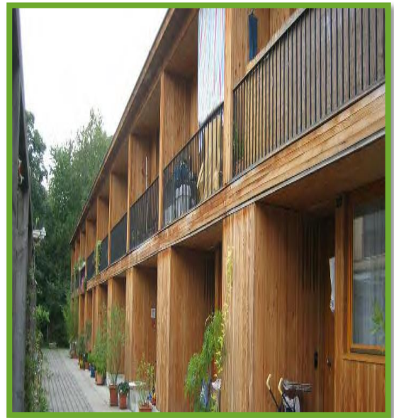
Figure 3.11 : construction bois à Oberwiden près de bale
