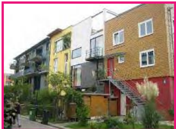
Figure 3.9 : diversité d'architecture, vauban, fribourg
