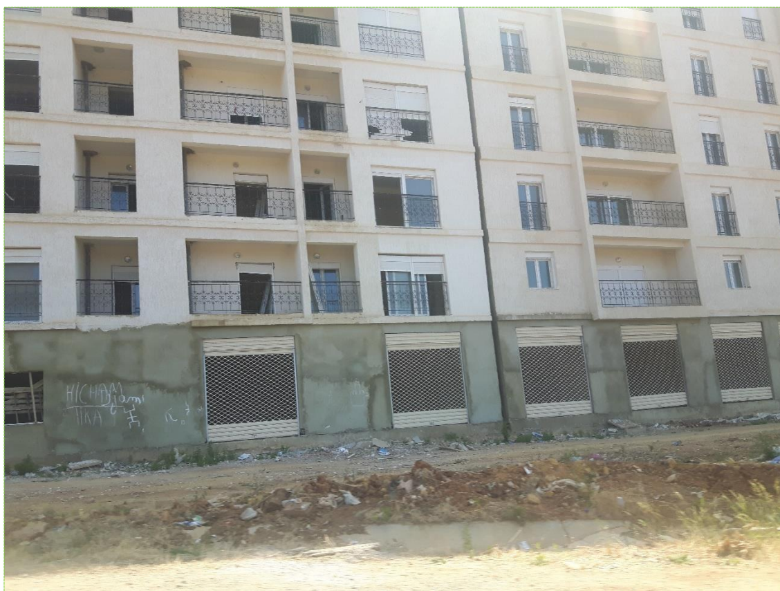
Figure 3.7 : état des lieux habitat collectif, sur site.
