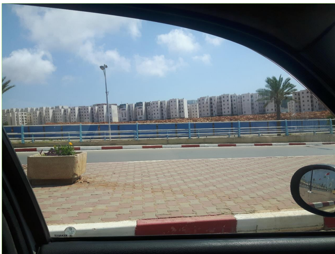
Figure 3.8 : état des lieux habitat collectif, sur site.
