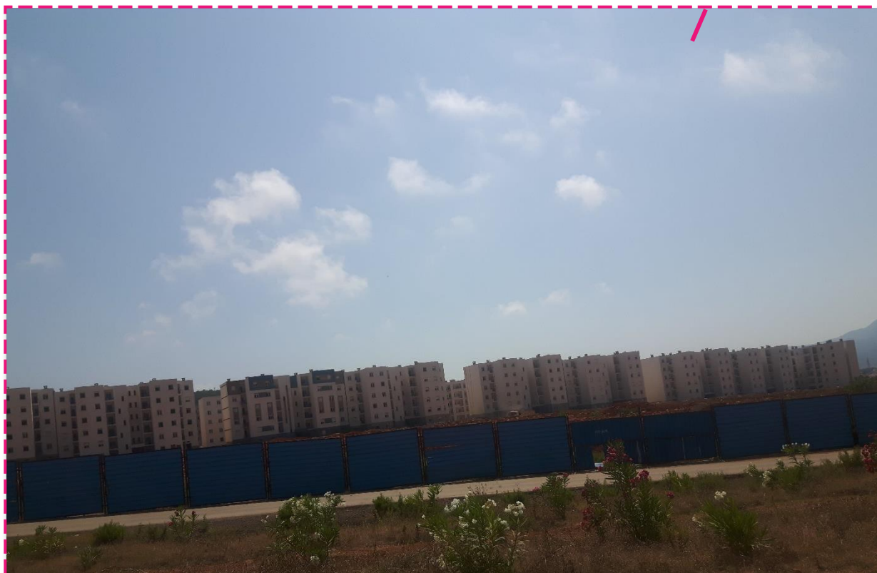
Figure 3.6 : état des lieux habitat collectif, sur site.
