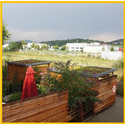
Figure 3.14 : Toiture végétalisée sur bâtiments annexes Quartier Rieselfeld, Fribourg .
