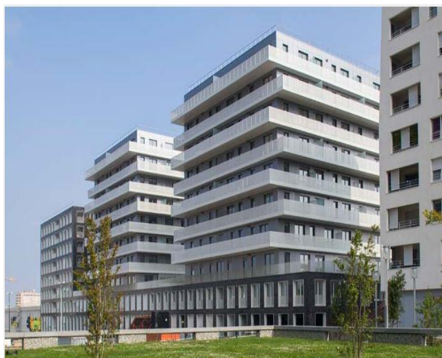
Figure 19. Green Home à Nanterre. Architecte : Atelier Zundel Cristea
