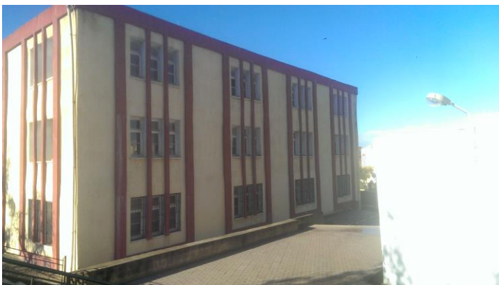
Figure 19 façade 01 de l'institut d'architecture blida le 07/12/2017
