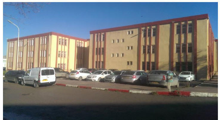
Figure 18 façade 02 de l'institut d'architecture blida le 07/12/2017
