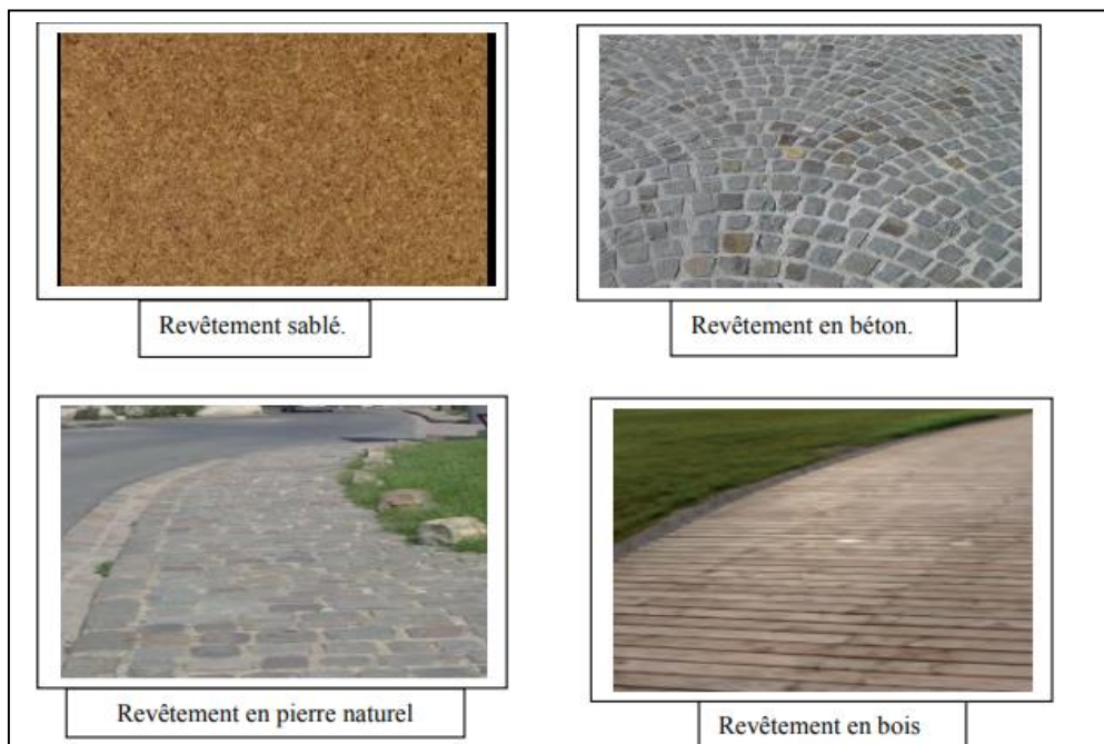
Figure 2.19 Les différents types des matériaux de revêtements Source : AROUL Khadidja -thèse Pour une amélioration de la qualité de l’espace public -2017
