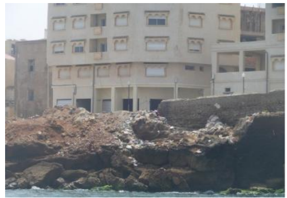
Figure 45 :vue coté nord sur la bande côtière a gyot-ville.Source : photo prise a partir du lieu, 17/02/2018
