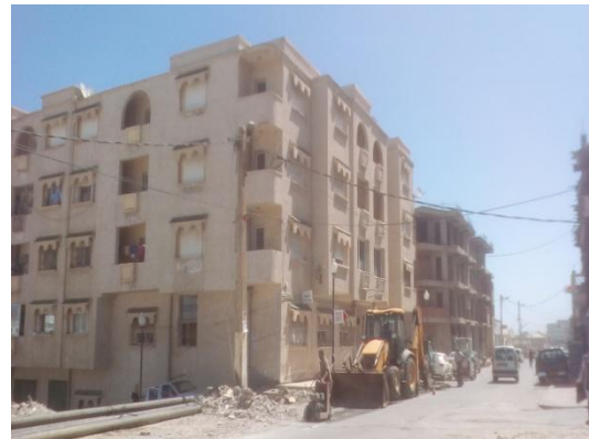
Figure n 31: façade type ressenté a gyot-ville .source : photo prise a partie de lieu, 17/02/2018.
