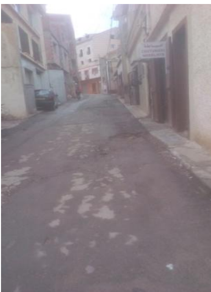
Figure 36: vue sur une rue secondaire a gyot-ville. Source : photo prise a partir du lieu, 17/02/2018
