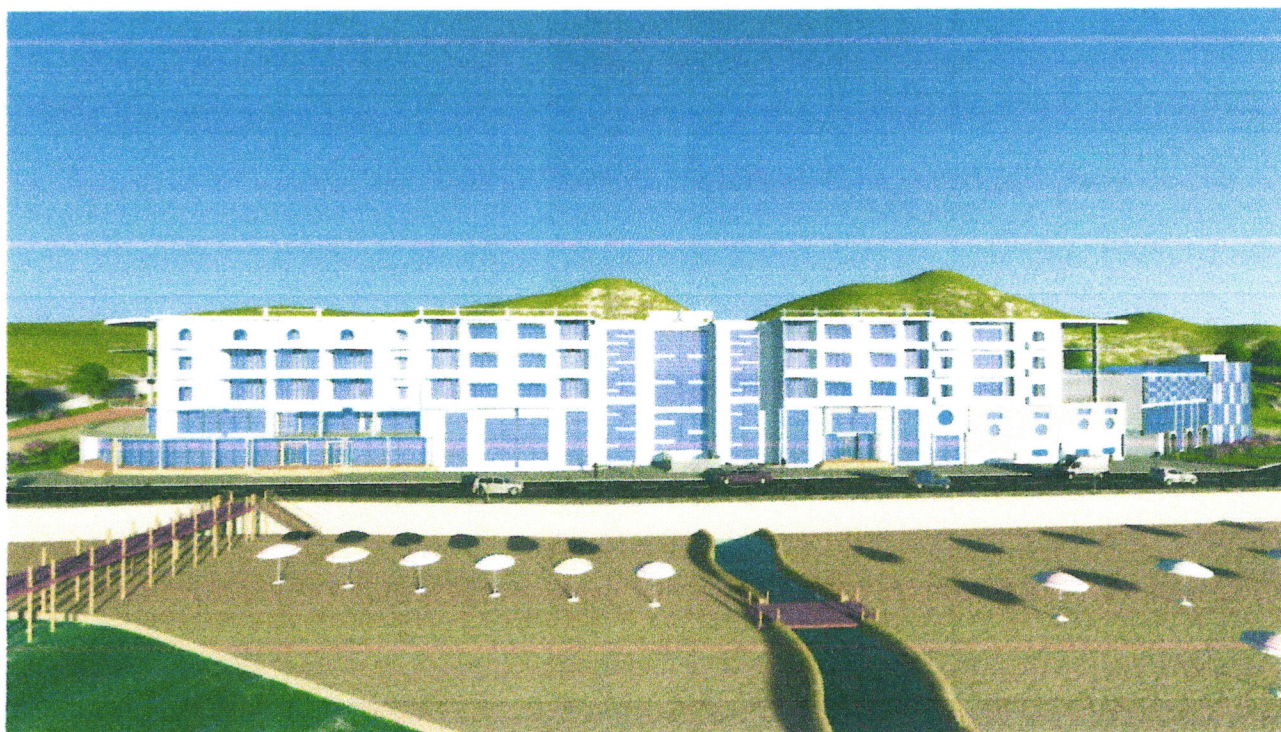
Vue sur la façade maritime
