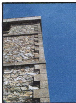
Fig. le chainage d'angle -dortoir 02
