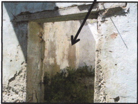
Fig03 : fenêtre linteau en bois.
