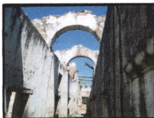
Fig. Etat de plancher dortoir 02
