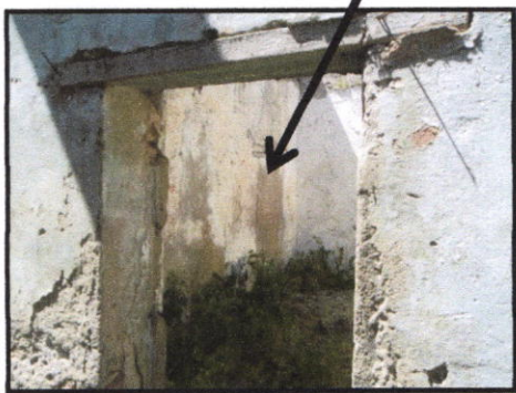
Fig03 : fenêtre linteau en bois.
