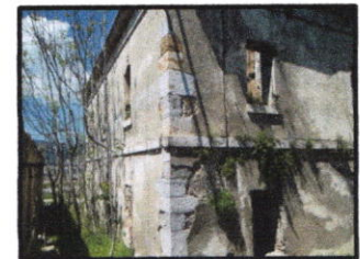
Fig. le chainage d'angle -dortoir 01
