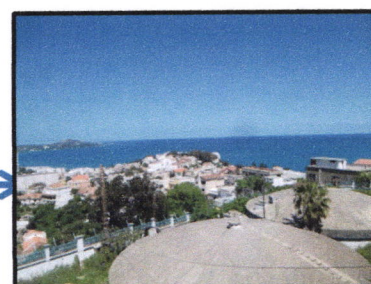
Fig. les châteaux d'eau
