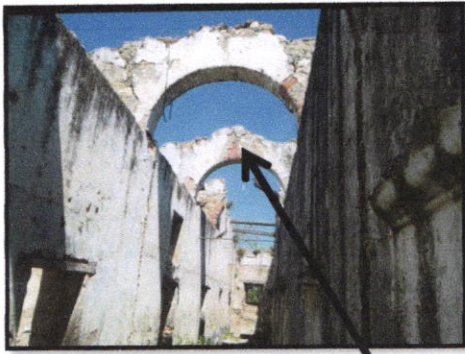
Fig01 : couverture état actuelle.
