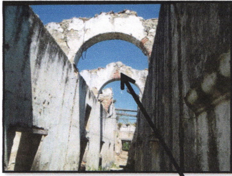
Fig01 : couverture état actuelle.
