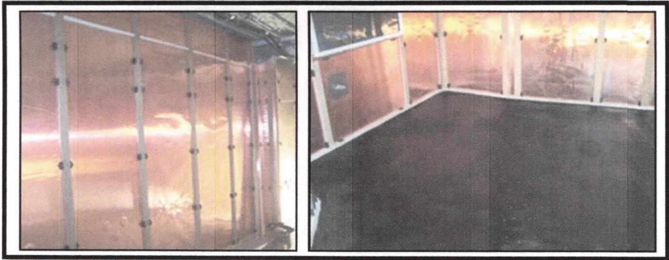
Fig. : Blindage radiofréquence en cours de réalisation
