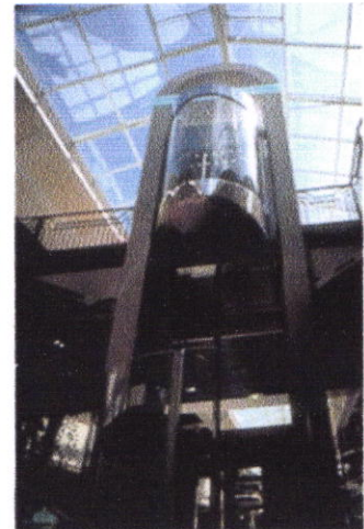
Figure 52 : Circulation verticale, ascenseur panoramique
