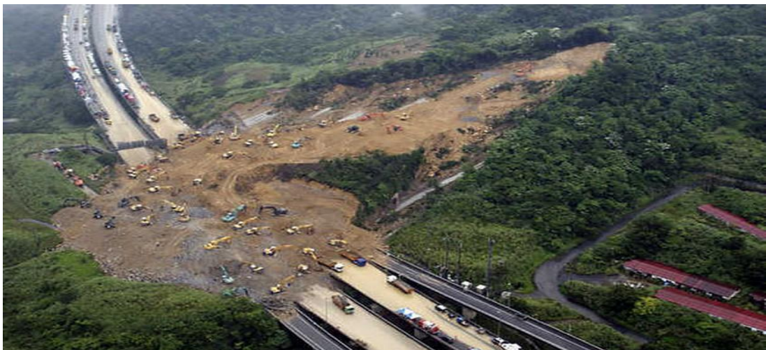
Figure 1.4 : un glissement de terre.
