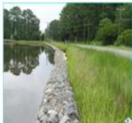
Exemple d'un gabionnage (gabion cage) au bord d'une rivière
