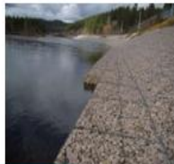
Exemple d'un gabionnage (gabion cage) au bord d'une rivière
