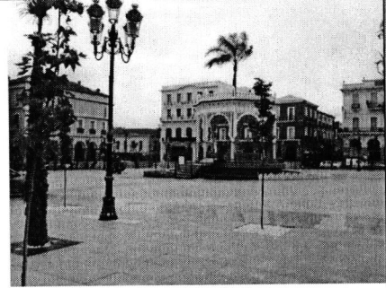
Photo 38. Façades (Place Toutes)
