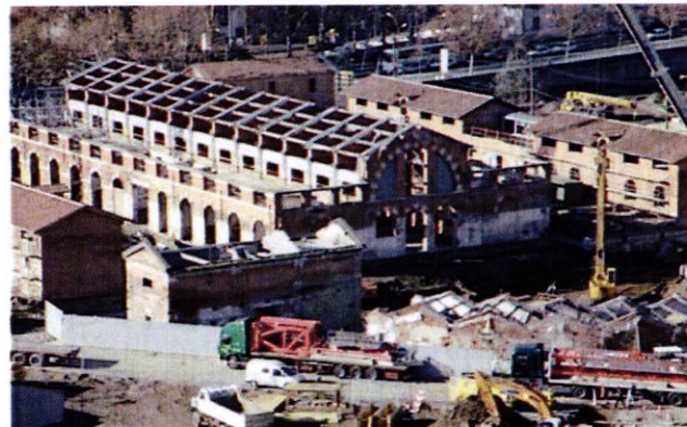
Figure 20 : le bâtiment sous chantier
