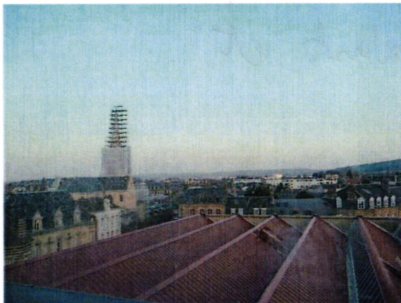
Figure 11 vue sur la toiture
