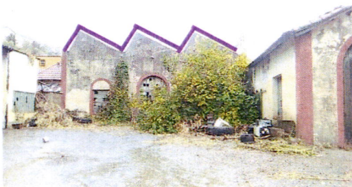
Figure 71 : vue sur les sheds de l'atelier source : auteur
