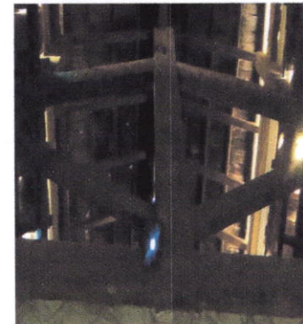
Figure 67 : ferme en bois de la partie B source : l'auteur
