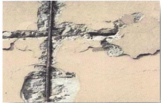
Fig. La corrosion
