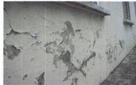
Fig: deterioration par l'humidité
