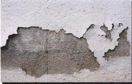
Figure 30 : impacte de l'humidité sur le revêtement
