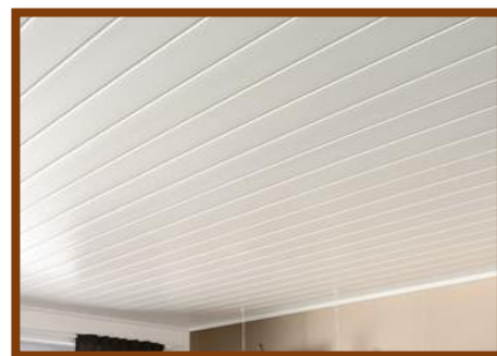
Figure: Faux plafond en PVC
