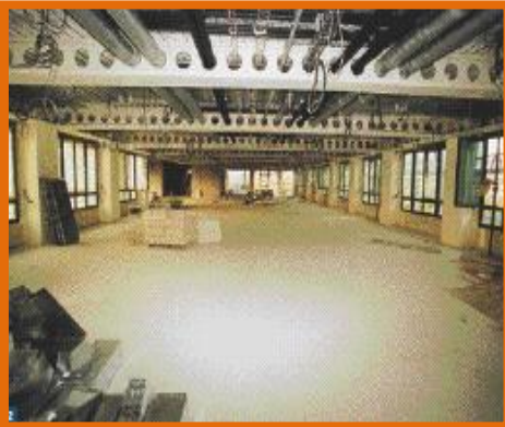
Passage des gaines par les alvéoles
