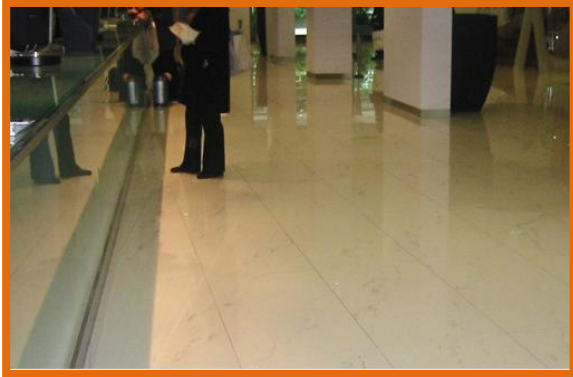
Les carreaux de marbres pour l'accueil et la circulation
