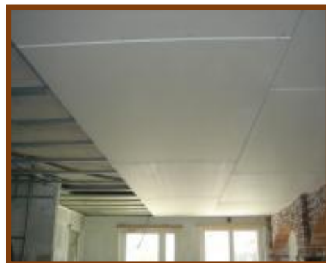
Figure: Faux plafond en plaques de plâtres
