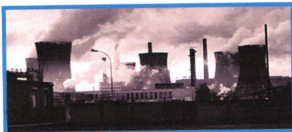
Photo 08 : VILLE INDUSTRIELLE A HOMBURG. Source : http://www.hombourghaut.fr/site/mairie_services_rens_risques02.php
