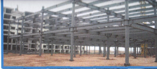
Photo 29 : STRUCTURE D'UN HANGAR. Source : https://fr.made-in-china.com/
