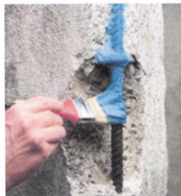
Fig (50): l'utilisation de la peinture hydrofuge source http://devispeinture.org/
