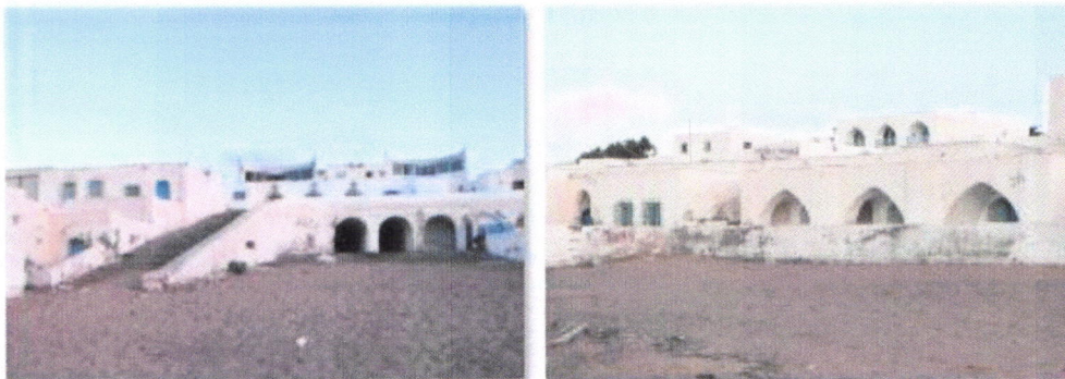
Fig (81) :Etat actuel des stations balnéaires en Algérie (Matares Tipasa). État de friche touristique
