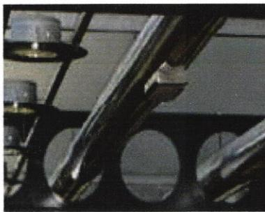
***Poutres alvéolaires permet le passage des gaines.***
