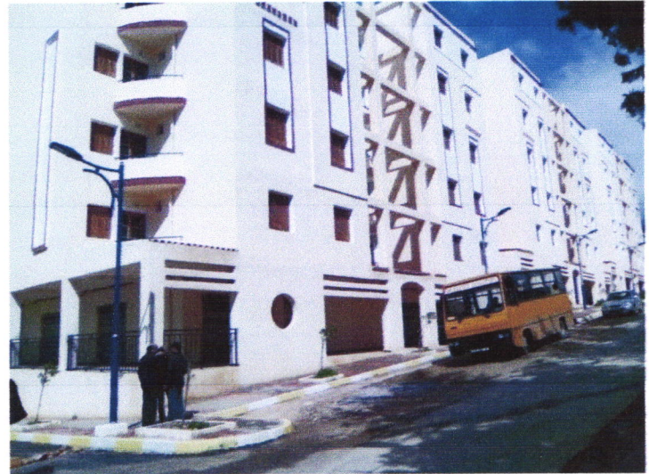
Fig25 : 130 logements RHP zougala
