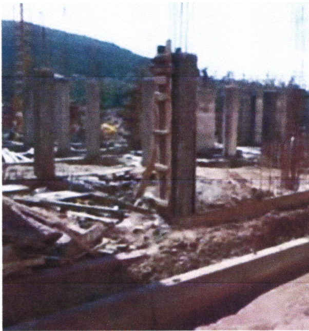
Fig26 : 15 logements RHP zougala
