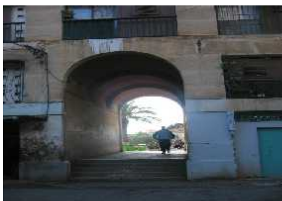
Figure 36 : photo de passerelle Source : Google image
