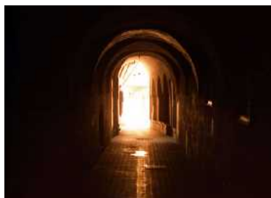
Figure 37 : photo de passerelle Source : Google image
