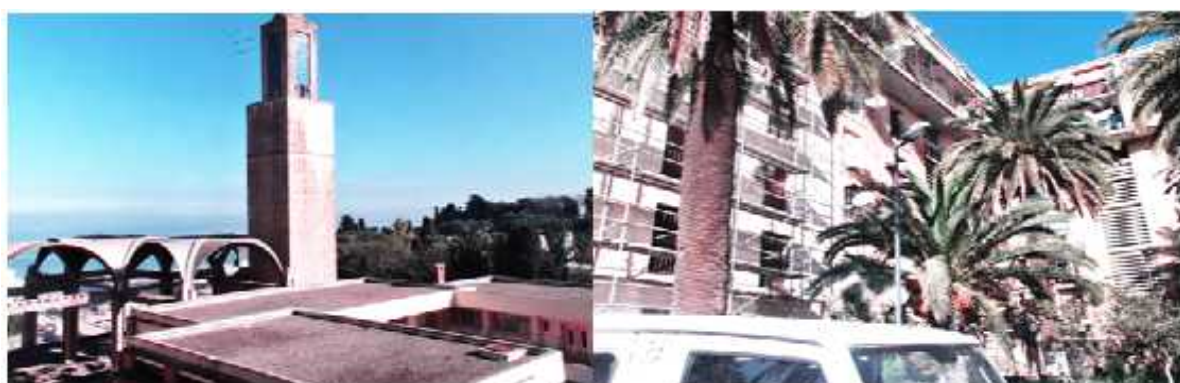
Figure 30 : vue sur les différents blocs qui font partie de la cité diar el mahçoul
