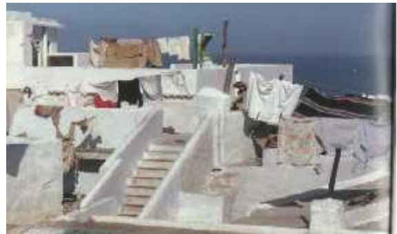
Figure 41 : toit de terrasse Source : Google image
