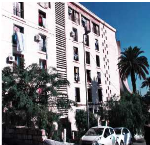
Figure 28 : vue sur le projet
