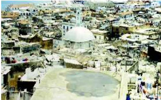
Figure 40 : toit de terrasse Source : Google image
