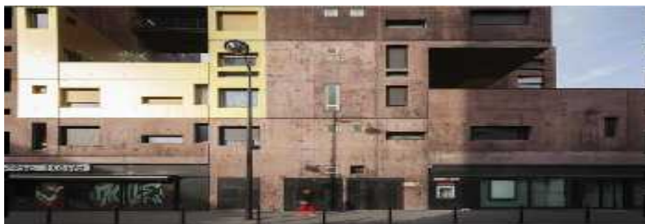
Figure 26 : Vue sur la façade sud Source : www. architizer.com
