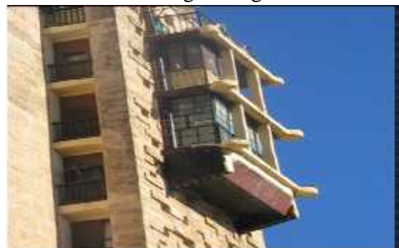
Figure 45 : les balcons saillant Source : Google image
