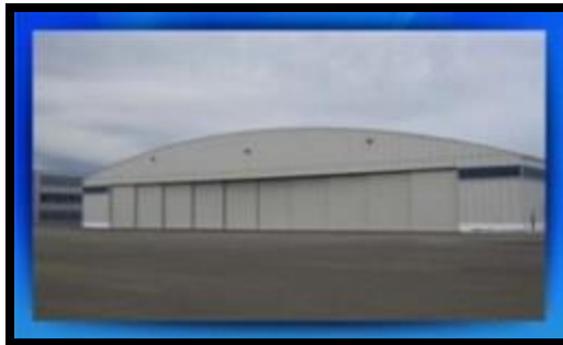
Figure I.3. Hangar du Centre de maintenance de Tassili Airlines
