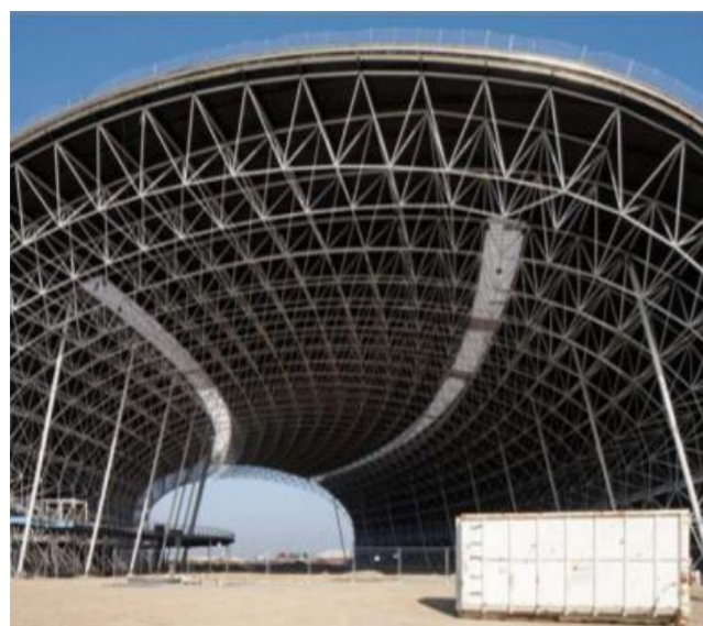
Figure 6.42 : poutre triangulée en arc. Source : cahiers-techniques-batiment.fr
