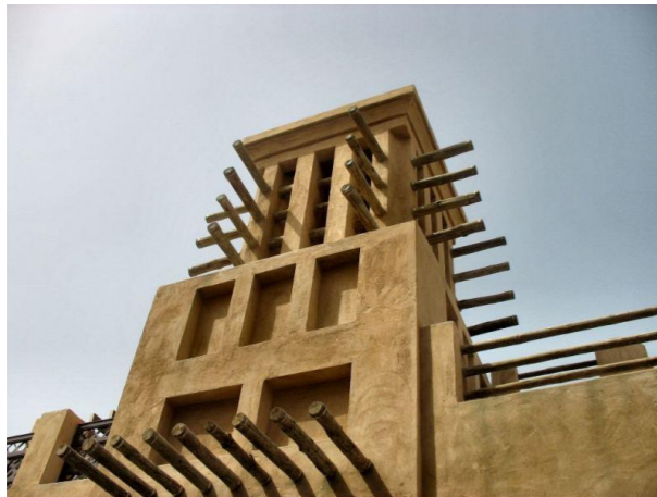
Figure 6.32 : Tour à vents à Timimoune.
