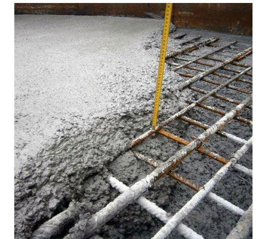
Figure 6.46 : Mise en œuvre du béton armé.
