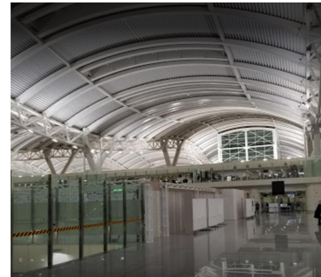
Figure 6.44 : toiture en treillis de l'aéroport d'Alger. Source : aps.dz
