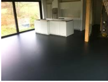
Revêtement du sol
