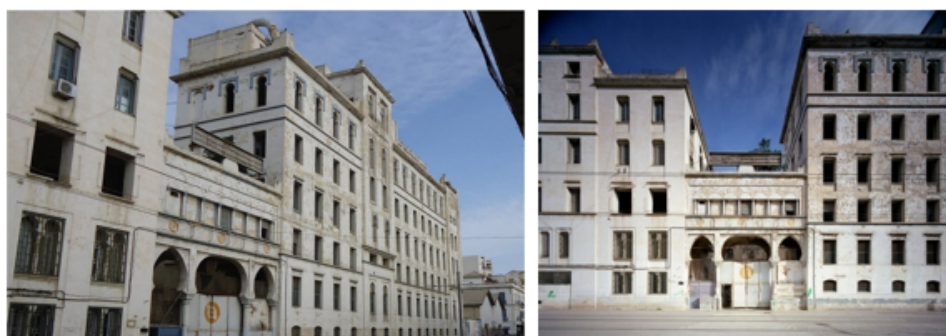
FIGURE III.32 — Vue sur la minoterie Narbonne
