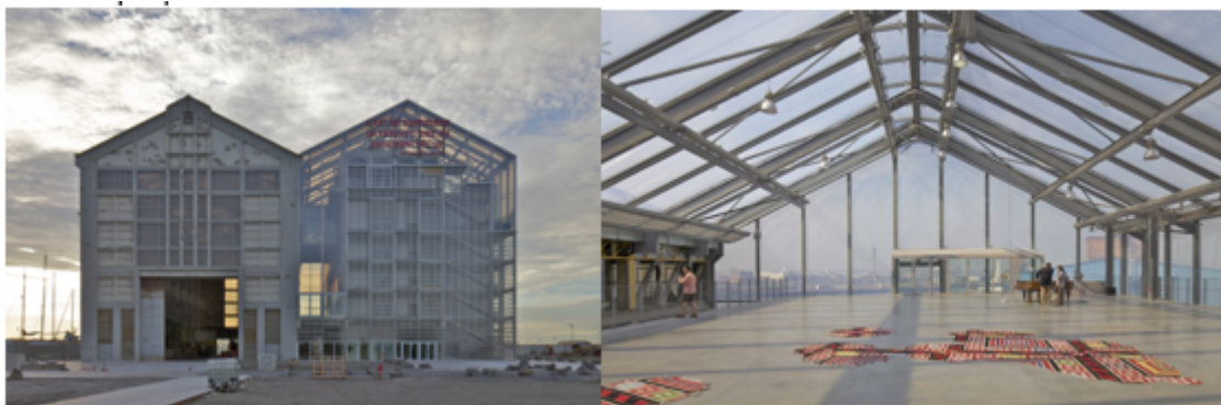
FIGURE III.47 — Enveloppe métallique intérieur du FRAC
