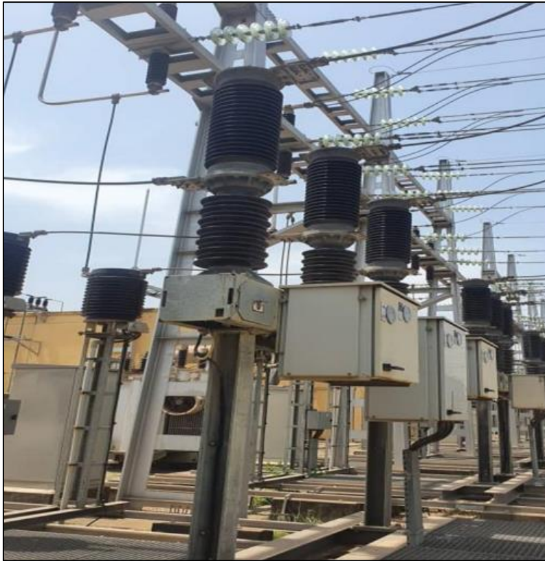
Figure I.13 Disjoncteur
