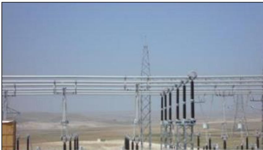
Figure I.14 Jeux de barres
