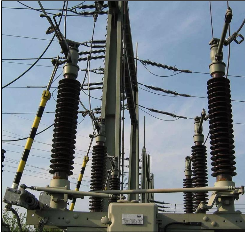
Figure I.12 Sectionneur
