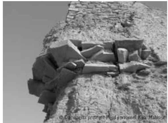
Figure 8 un encorbellement en pierre à KSAR d'Aghlad Source : Architecte Kaci MAHROUR, Timimoun, 2002.
