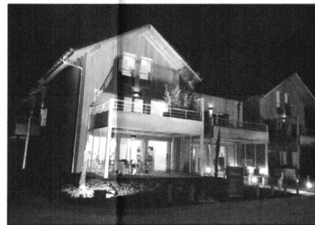
Figure II.54 : vue d'extérieur de l'I-lodge
