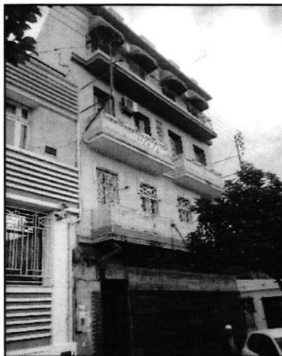
Figure 57 : Extension moderne d'une Maison coloniale Source : auteur
