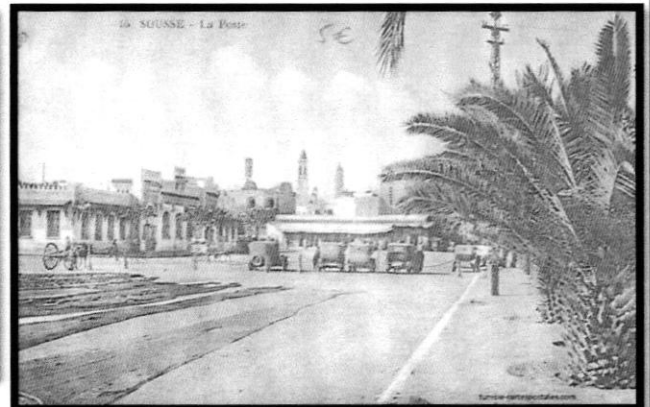
Figure 13; photo de l'hôtel des postes à Sousse
