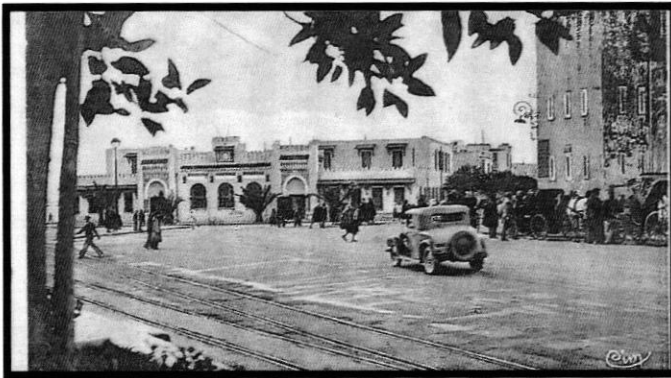
Figure 12; photo de l'hôtel des postes à Sousse
