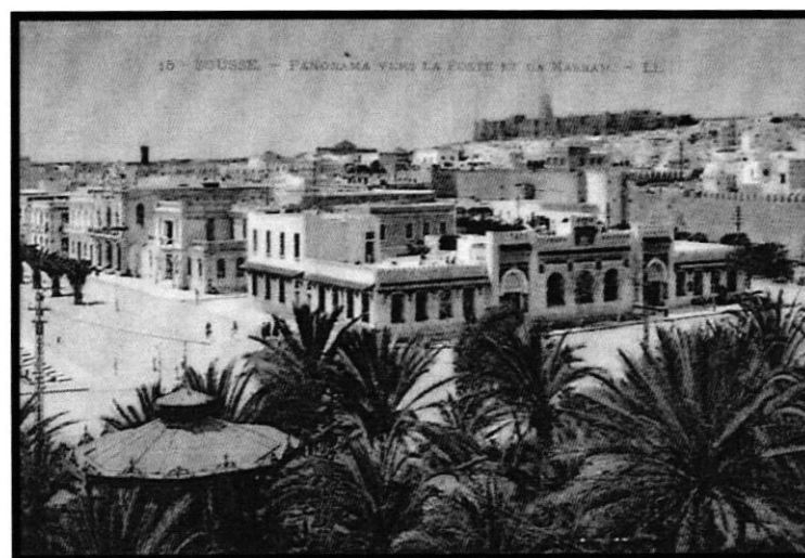
Figure 14 : photo de l'hôtel des postes à Sousse
