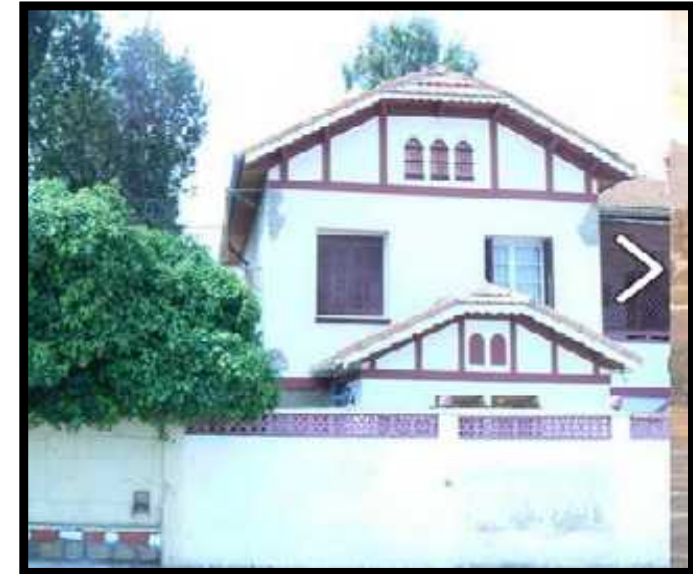
Fig1: une maison colonial
