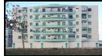
Figure 6:façade nord de LSP
