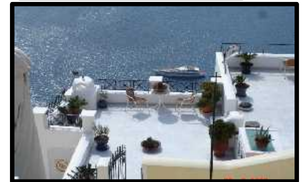
Fig2:Toiture terrasse d'une maison
