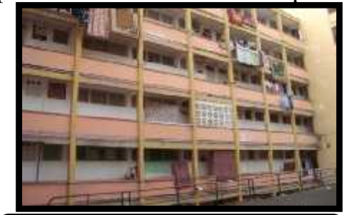
Fig5: Une bâtisse d'une cité a Boufarik qui est une ville intérieure
