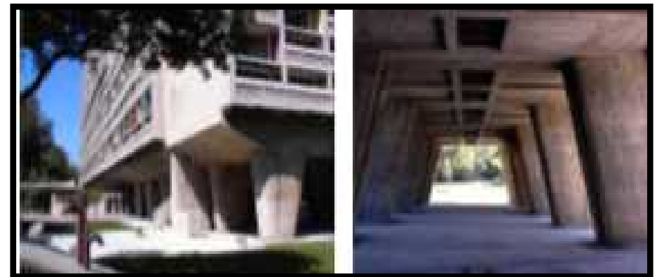
Fig3: construction sur pilotis
