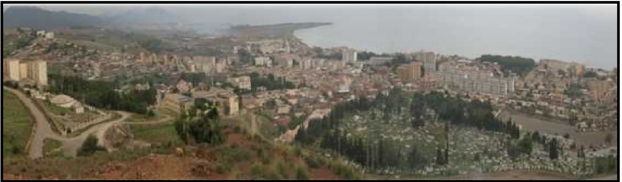
Fig1: Vue générale sur l'extension ouest-
