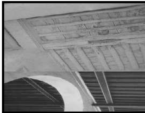
Fig3: l'utilisation du bois au plafond
