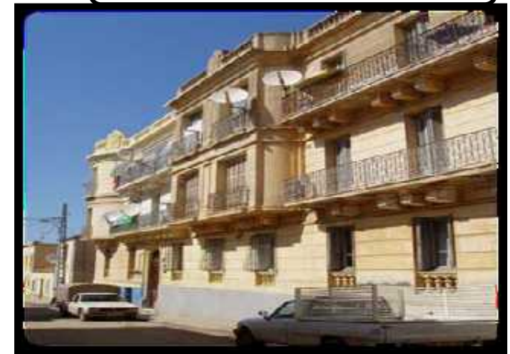
Fig2:Façade d'un immeuble collectif
