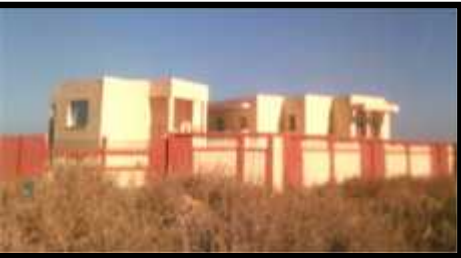
figure 1: La façade Ouest de protection civile
