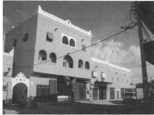
Fig.3.10 Travaux de restauration
