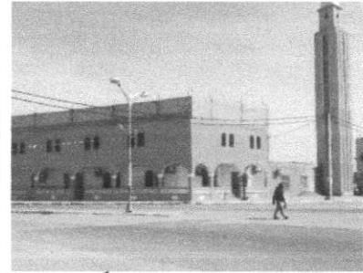
Fig.3.22 Façade de la mosquée Source: auteur 2018
