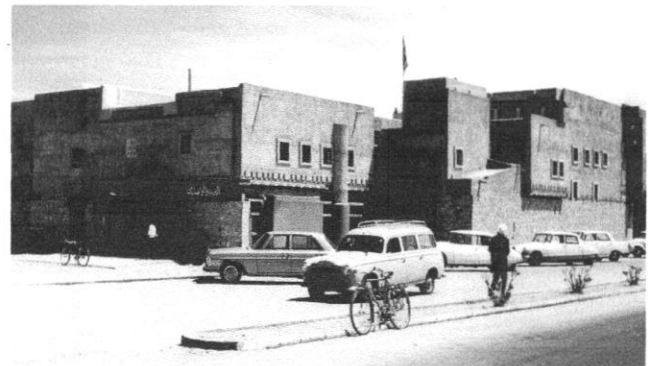
Fig.2.42 Hôtel des postes de Ghardaïa | 1966-67
