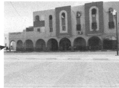
Fig.3.24 Façade d'un bâtiment collectif. Source: auteur 2018
