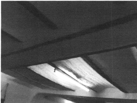
Fig.2.66 Les voûtains d'un plancher Source: Auteur 2018
