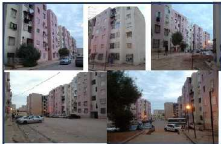
Figure 52: photos du DC 18. Ici l'ilot 18 en soirée prise par l'évaluateur
