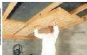
Fig 1 : rotation mécanique des dalles par la "roche au feu" entre la dalle et le faux plafond
