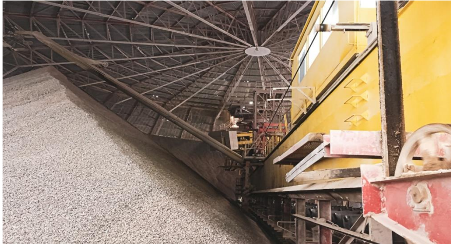
Figure I.9: Hall de pré-homogénéisation
